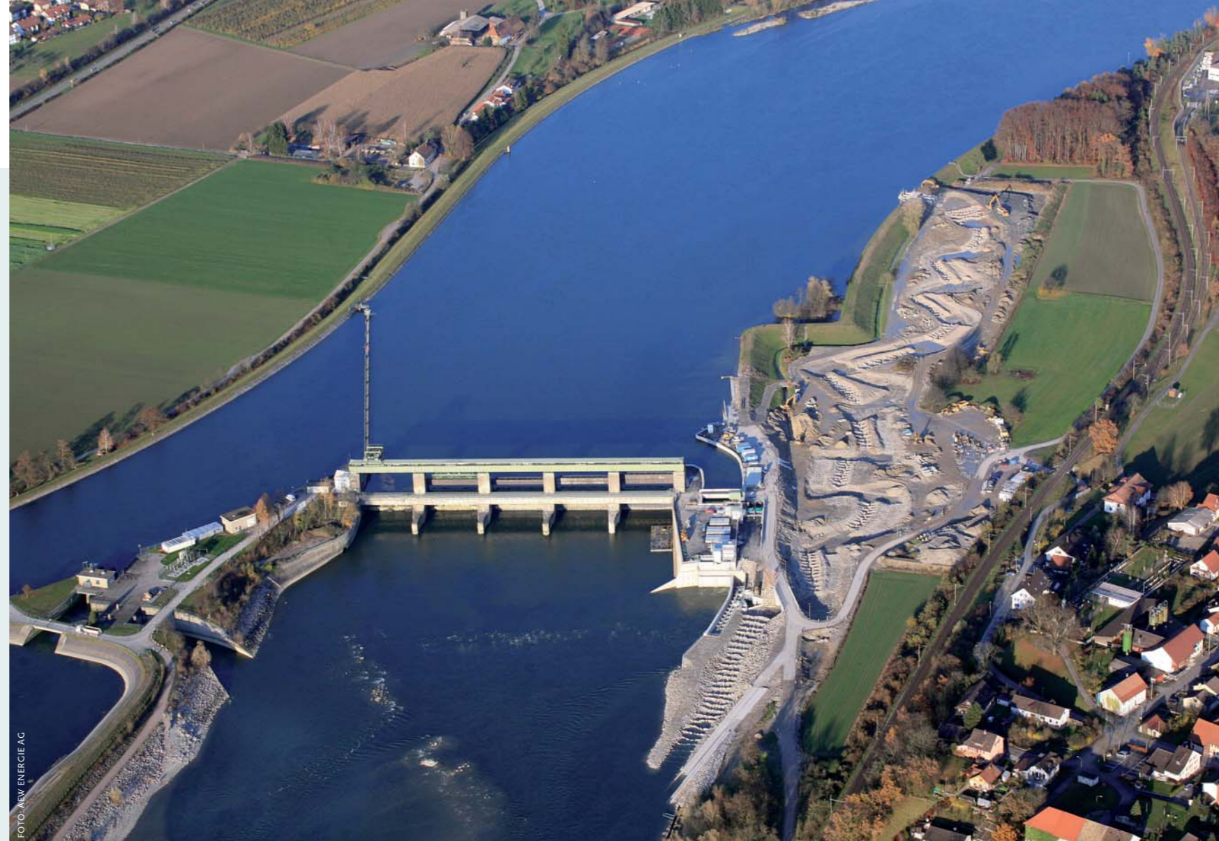
Bij de bouw van de waterkrachtcentrale Albruck-Dogern in de Hoog-Rijn is ook voorzien in een omvangrijke vispassage (rechts).
