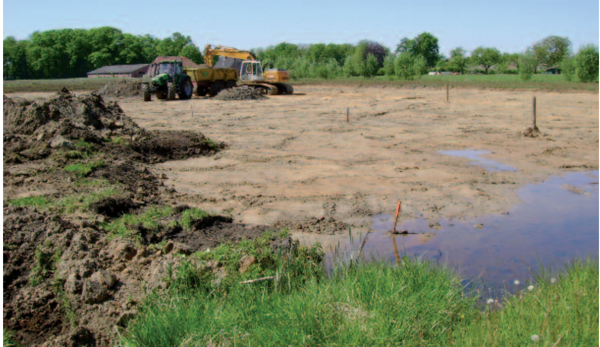
Foto 3. Ontgrondingswerkzaamheden bij de Lindense Laak (Vorden) (foto: Mark van Mullekom).
