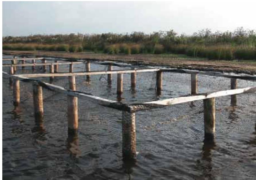
Enclosures in de noordelijke petgaten.
