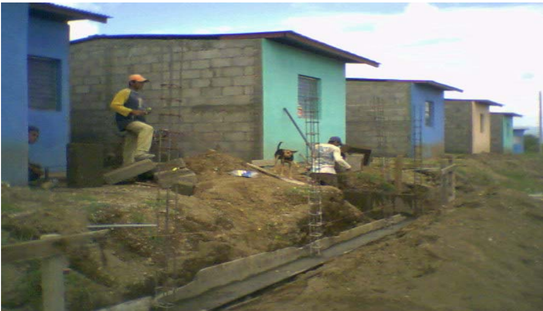
foto 3: toekomstige huizenbezitters in het Salto Transatlántico project bezig met het verstevigen van het talud voor hun huis
