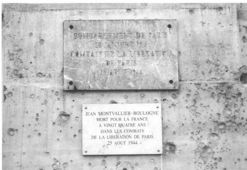
Le mur de l'École des Mines, photo M. Koffeman.
