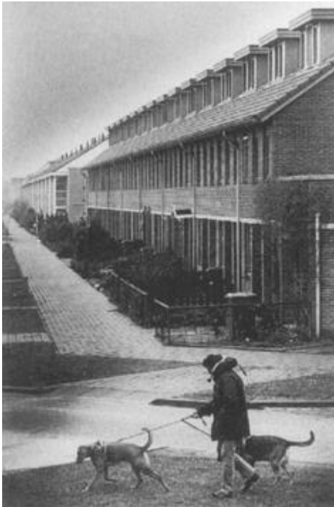
Construction de logements, Almere (Flevoland) (Photo Stephan Vanfleteren).
