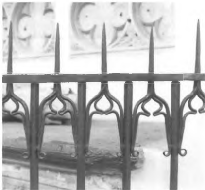
358 Detail van het hek (foto RDMZ, 2002).
