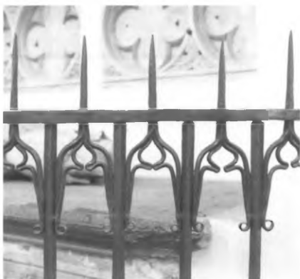
358 Detail van het hek (foto RDMZ, 2002).
